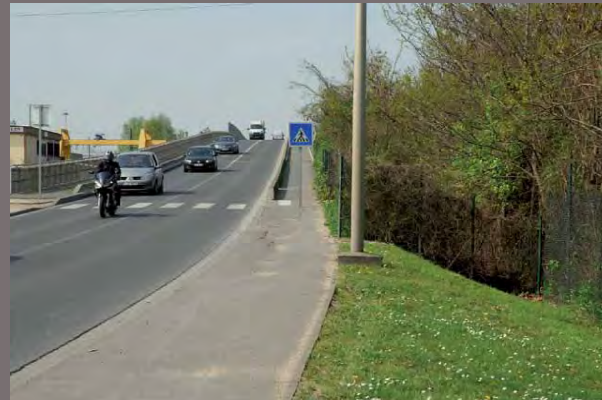
Valenton > Pont routier à rendre accessible aux PMR
