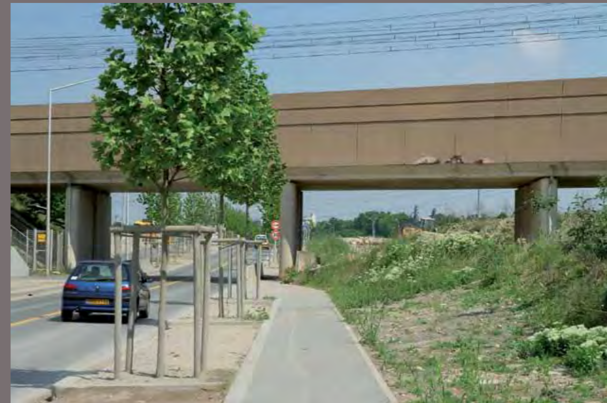
Valenton > Passage de la RD102 sous la voie TGV
