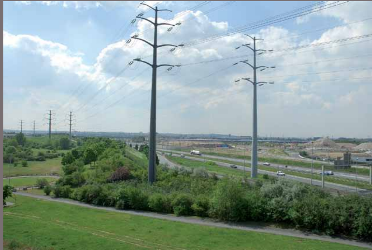
Créteil > Emplacement de la future passerelle de franchissement de la RN406
