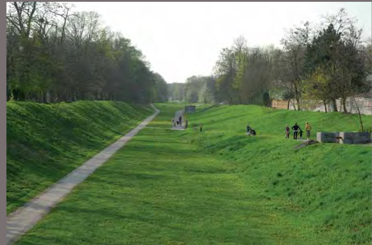
Villecresnes > La tranchée couverte
