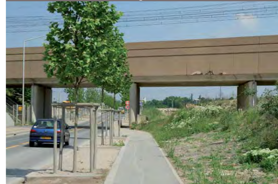
Valenton > Passage sous la voie TGV
