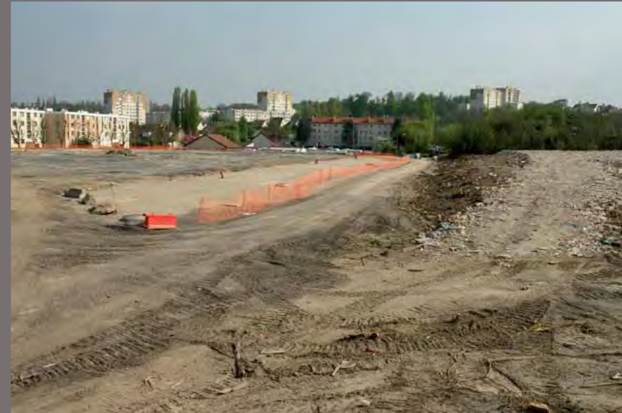
Limeil-Brévannes > Les remblais de mauvaise qualité
